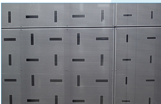
Perforerede aluminium plader, Pulverlakeret. Perforering R6 T9 med rektangulære huller i forskellige størrelser.
