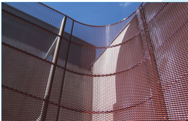
Valset aluminium strækmetal. Maske 115 x 48 x 20 x 1,5 mm.
