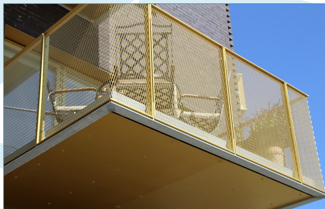
Bukket aluminium strækmetal. Maske 62,5 x 20 x 3 x 3 mm.
